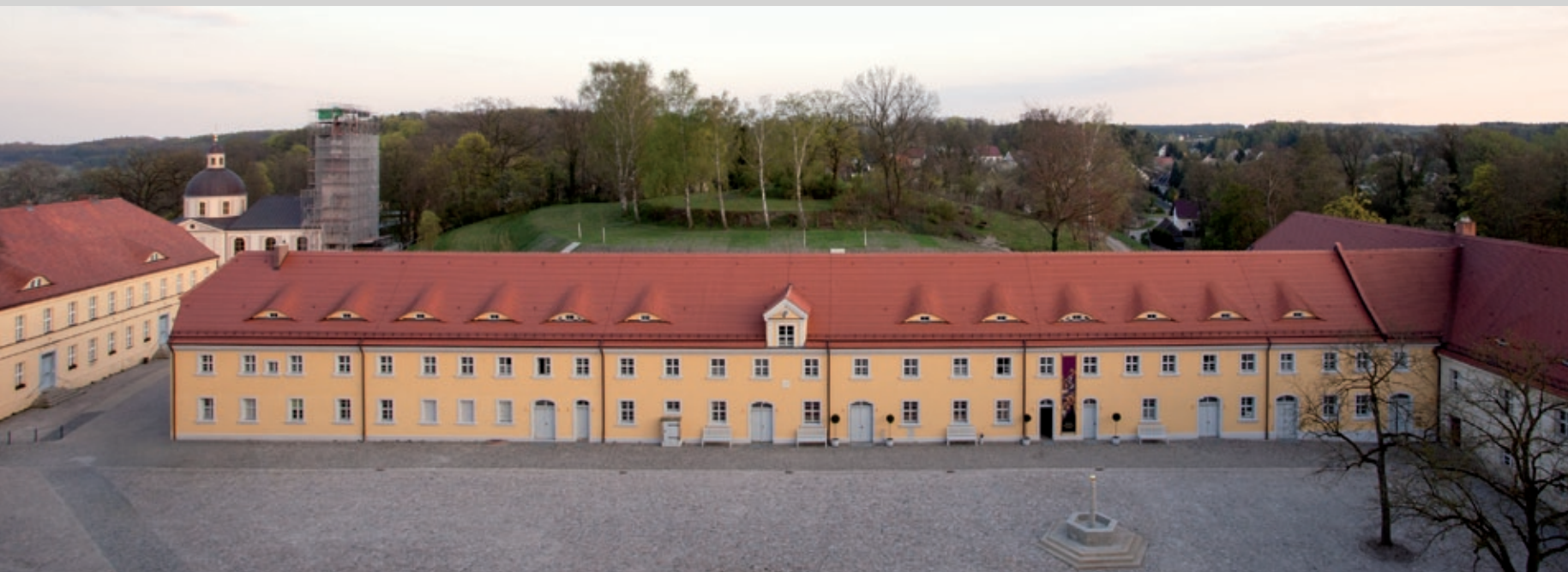
Kutschstallgebäude nach Fertigstellung | Foto: Stiftung Stift Neuzelle / A. Tauber
