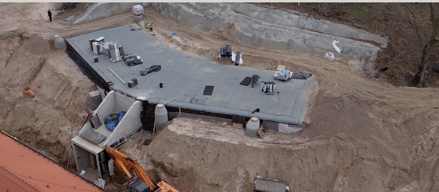
Kutschstallgebäude – Museumsneubau während der Bauphase | Foto: Stiftung Stift Neuzelle
