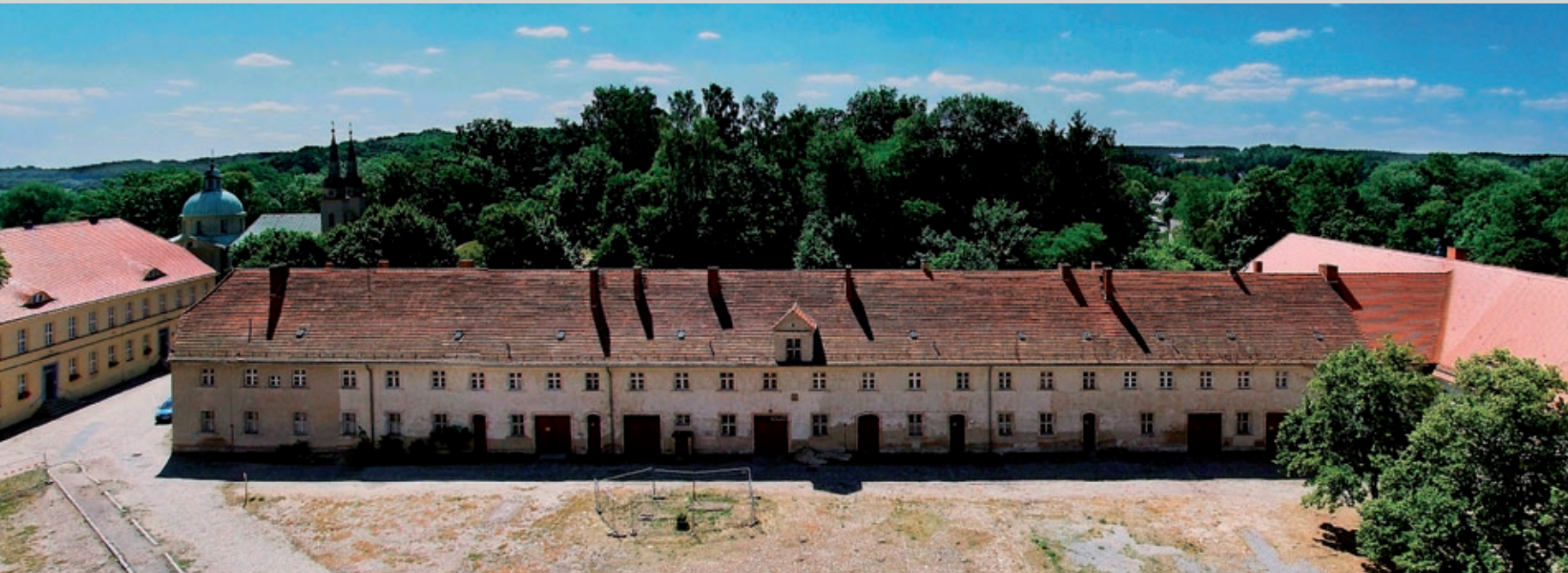
Kutschstallgebäude vor Baubeginn | Foto: BLB
